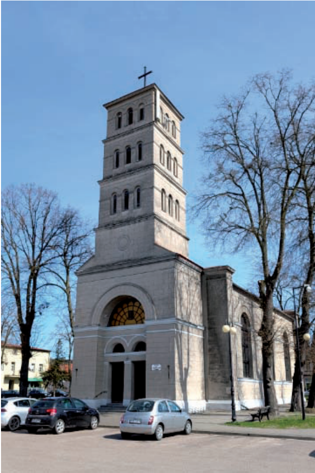
Planowane prace mają na celu zahamowanie postępujących procesów destrukcji i likwidację ich przyczyn
