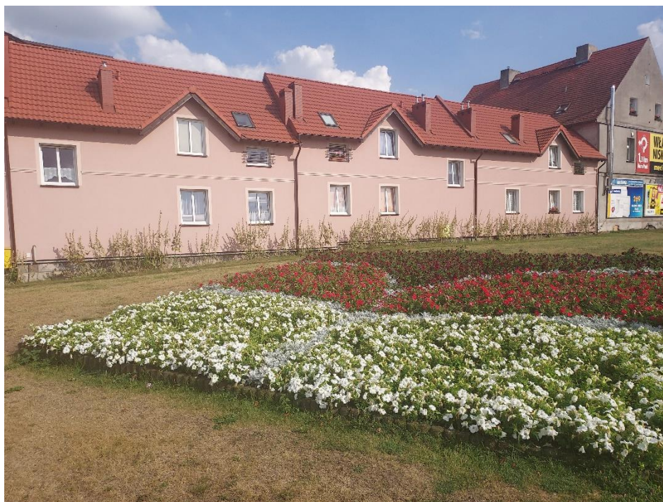
Rys 2 Stan istniejący, widok na kwietnik oraz towarzyszącą zabudowę
