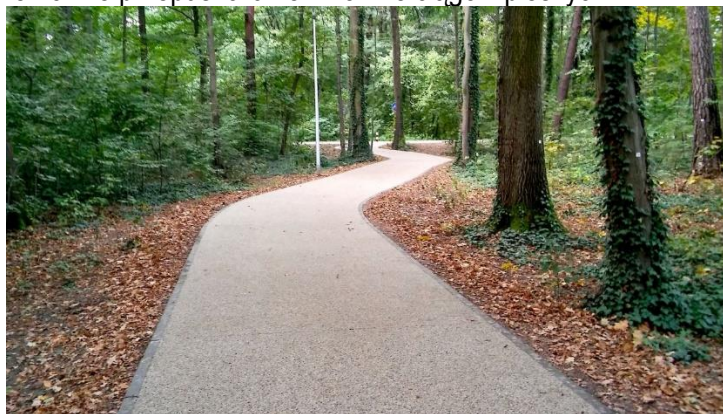
Rys. 4. Proponowany rodzaj nawierzchni przepuszczalnej
