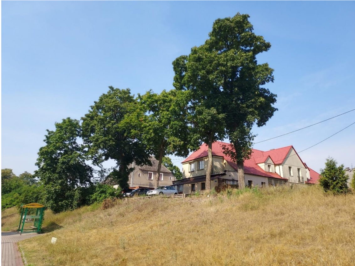
Rys.3. Stan istniejący widok na skarpe z wschodu w kierunku północno-zachodnim (Źródło: materiał własny)
