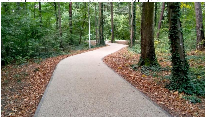
Rys. 5. Proponowany rodzaj nawierzchni przepuszczalnej
