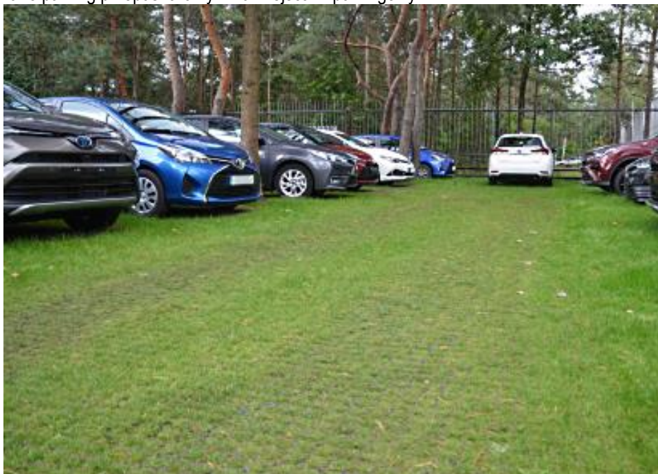
Rys. 7. Proponowany rodzaj parkingu – nawierzchnia trawiasta stabilizowana geokratą
